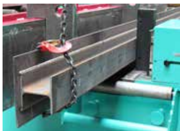
119 Redressage de poutrelles soudées Gelaste balk richten
