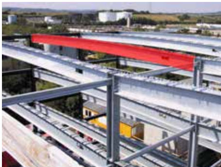
271 Pré-contraindre des poutrelles dans la construction métallique / Togen van profielen
